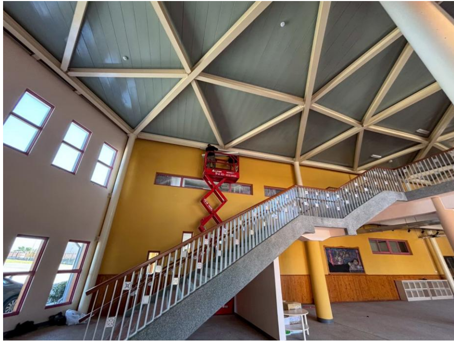
照片說明：2/10廠商施作接水盤
